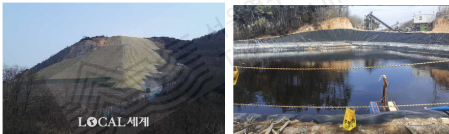
[그림 4-11] 하수슬러지 고화물 이용 폐석산 복구 전경(좌), 최근 침출수 발생 현장(우)
